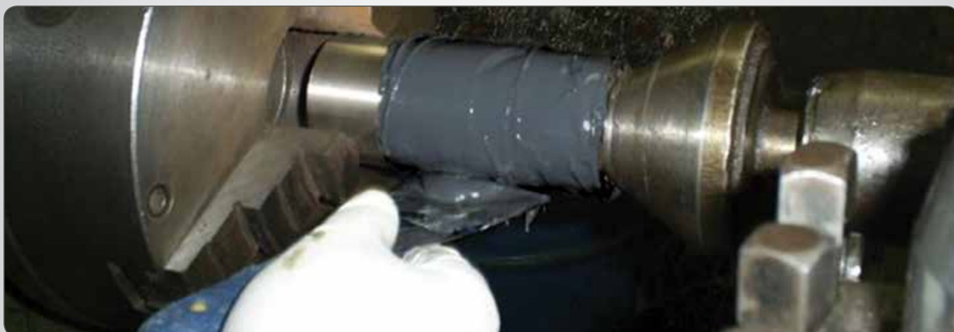
RECUPERAÇÃO DE EIXO COM O PLASTEEL MASSA 4:1
